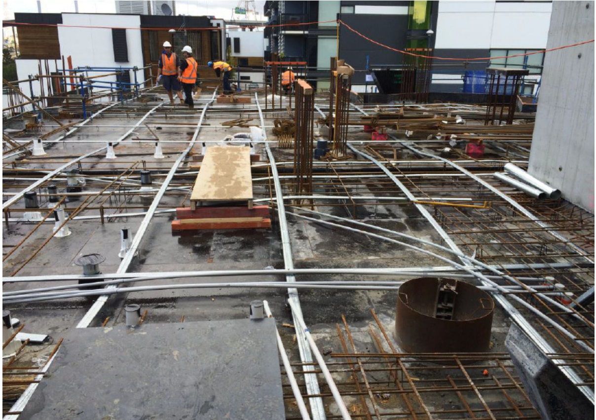
Level 2 Pour Preparation
